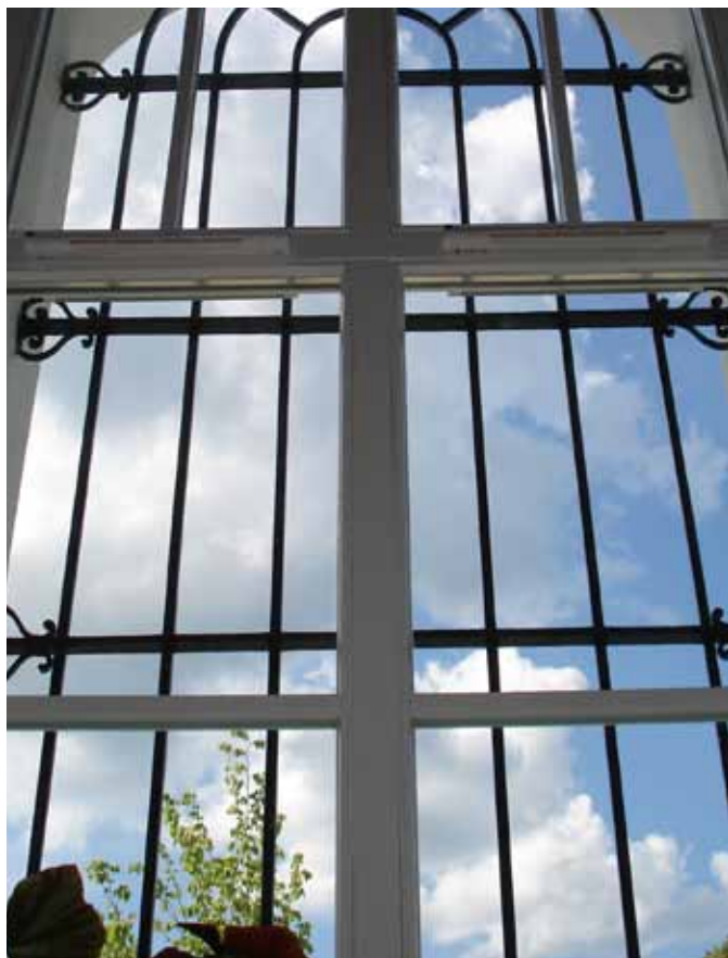
Приточные устройства, установленные в верхней части окна.
